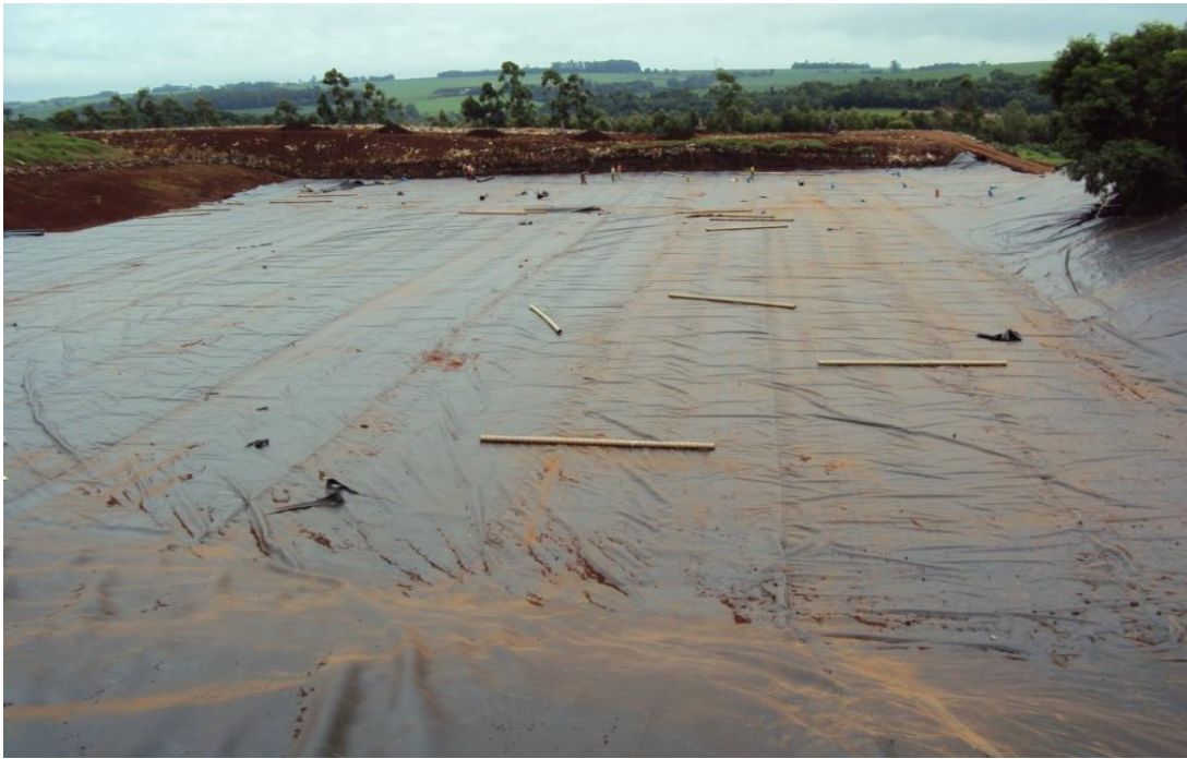
Figura 25 - Cobertura da área com a geomembrana protetora
