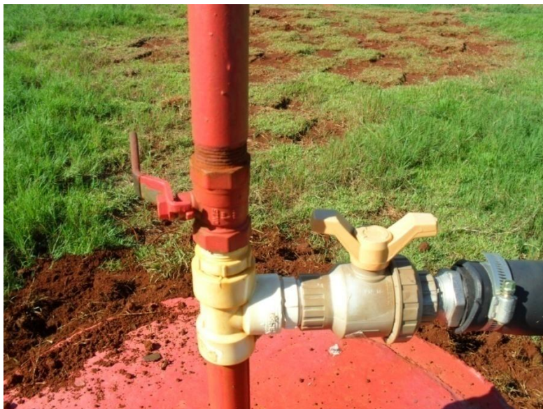
Figura 10 – Ponto 1 de coleta de biogás – Saída do queimador (célula 1)
