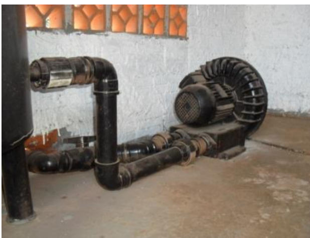
Figura 29 – Soprador do sistema
