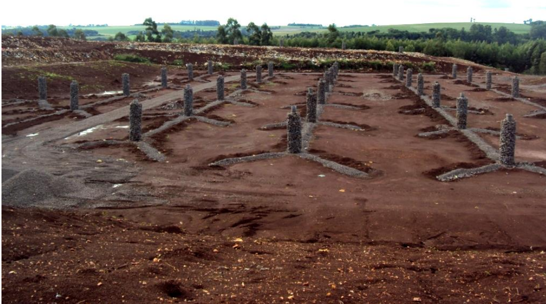
Figura 26 – Sistema de captação de chorume e biogás
