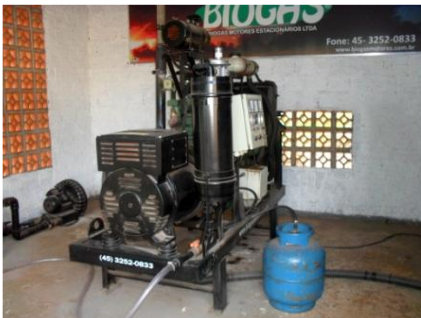
Figura 31 – Moto gerador movido à biogás
