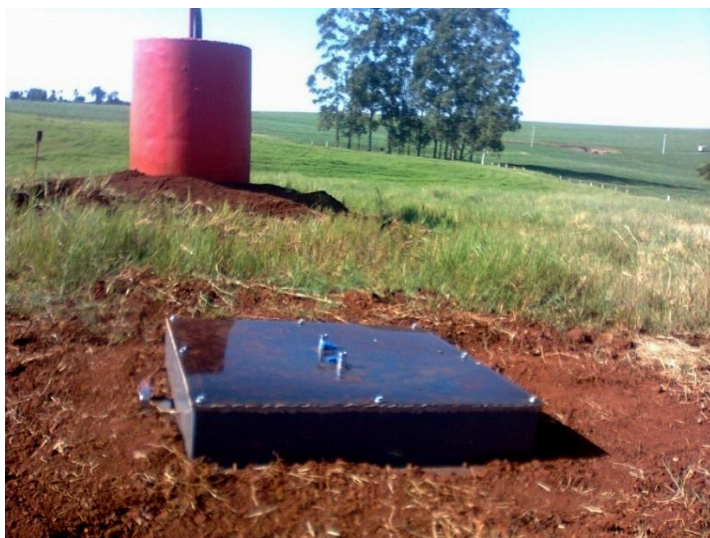
Figura 22 – Ensaio com placa de fluxo no Ponto 10 – cobertura de terra
