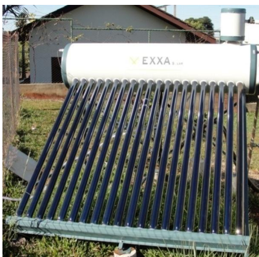
Figura 13: Coletor solar com tubos a vácuo tipo all-glass instalado na UNIOESTE, campus Cascavel.
