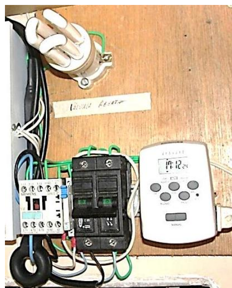
Figura 24: Timmer e controle da resistência de aquecimento auxiliar.
