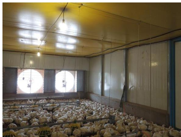
**Figura 21:** Vedação do Aviário *Dark House* com Isolamento Térmico (DHIT) - Face externa e interna
