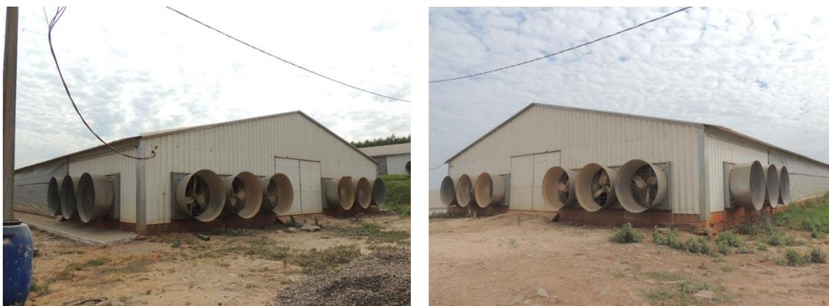
**Figura 17:** Aviário DHC – Face sul com sistema de exaustores, e laterais faces oeste e leste, respectivamente
