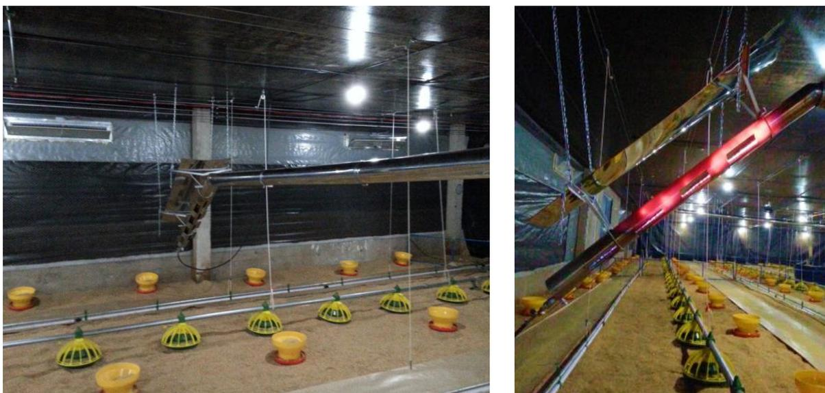
**Figura 18:** Tubo radiante convectivo
