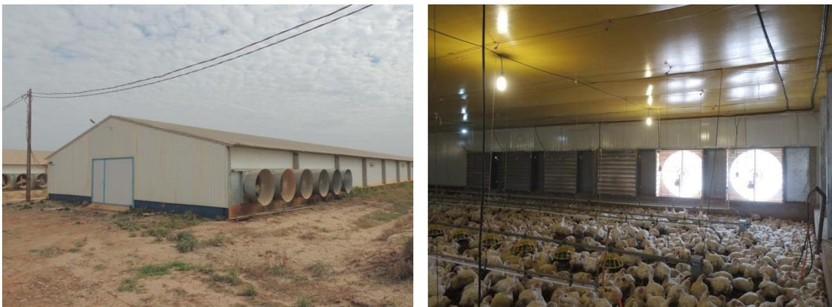
**Figura 24:** Sistema de exaustores na extremidade sul – externo e interno ao aviário DHIT
