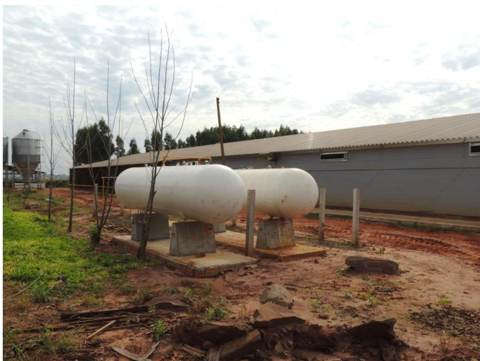
**Figura 27:** Tanques de armazenamento de GLP – P1000
