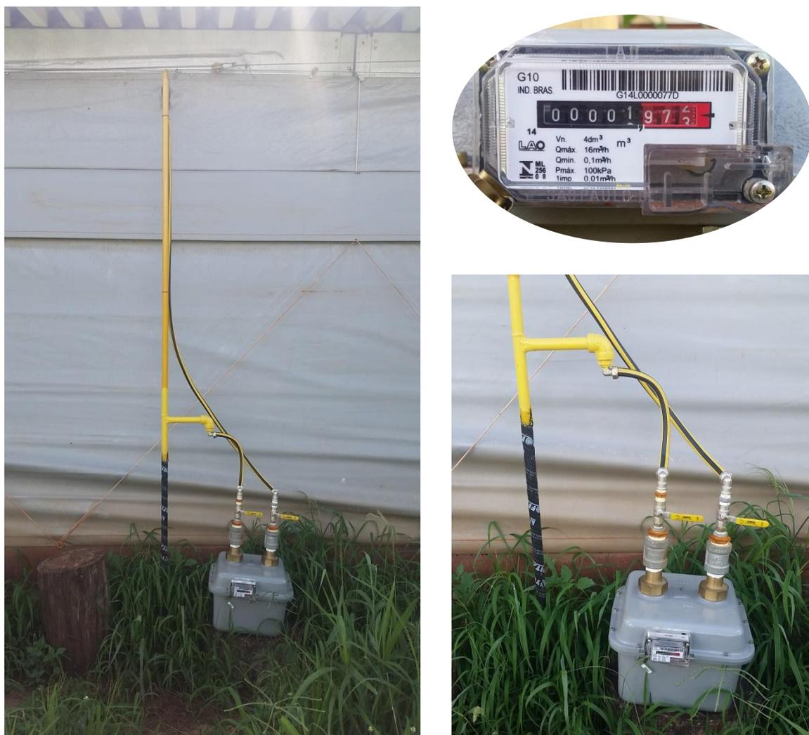
**Figura 37:** Equipamento e painel de registro do medidor volumétrico de gás G10 instalado no aviário DHC
