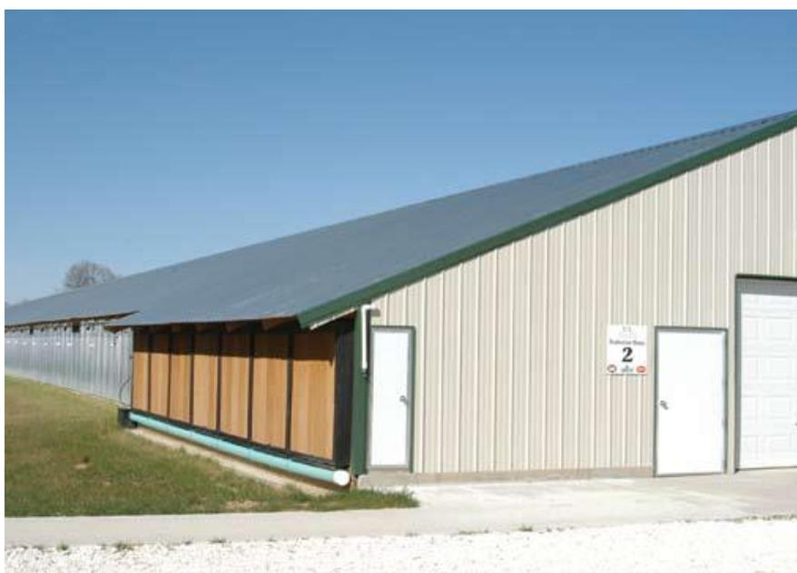
**Figura 07:** Sistema *Pad Cooling* instalado na entrada de ar do aviário
