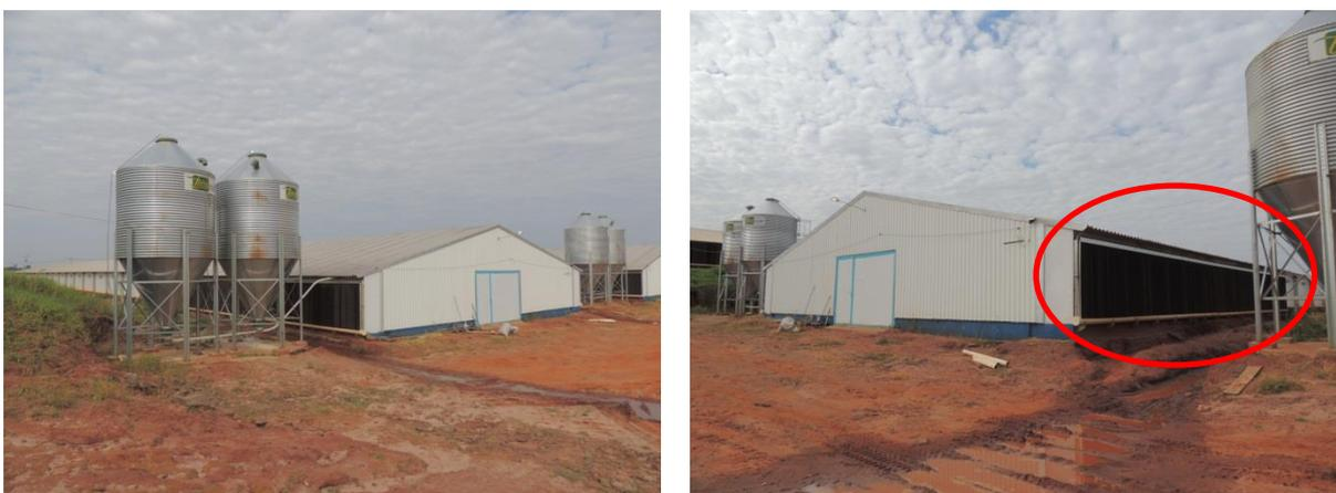
**Figura 23:** Aviário DHIT - Sistema de painel evaporativo ou *pad cooling*, nas faces oeste e leste, respectivamente
