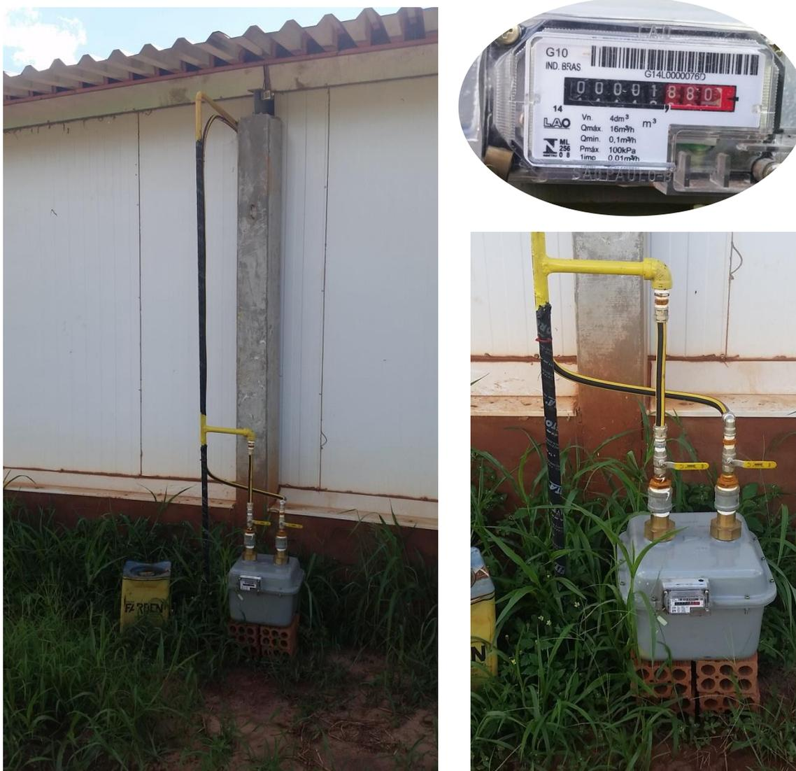
**Figura 38:** Equipamento e painel de registro do medidor volumétrico de gás G10 instalado no aviário DHIT (Fonte: Acervo do AUTOR, 2015)
