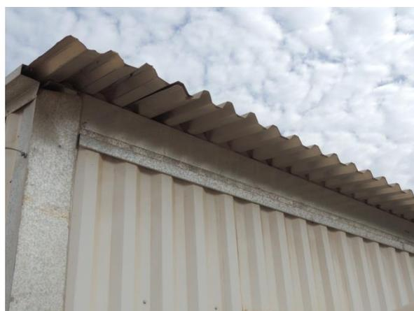
**Figura 15:** Aviário DHC - Forro polietileno preto e detalhe telha em alumínio 0,40 mm
