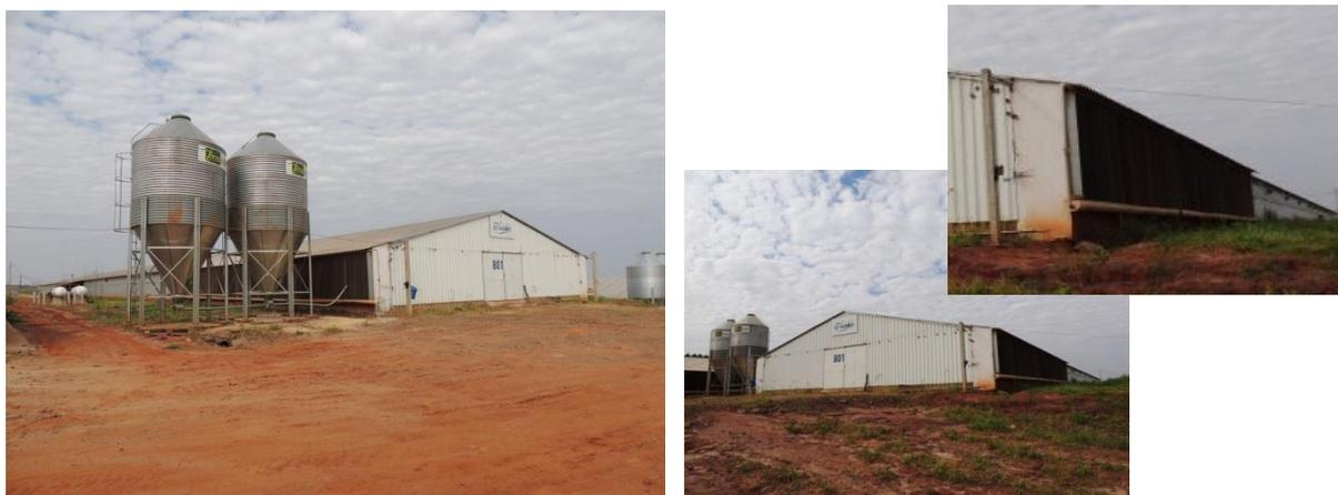
**Figura 16:** Aviário DHC - Sistema de painel evaporativo ou *pad cooling*, nas faces oeste e leste, respectivamente
