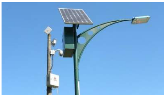
Figura 14: Geração fotovoltaica em iluminação pública. Fonte: Arquivo pessoal.
