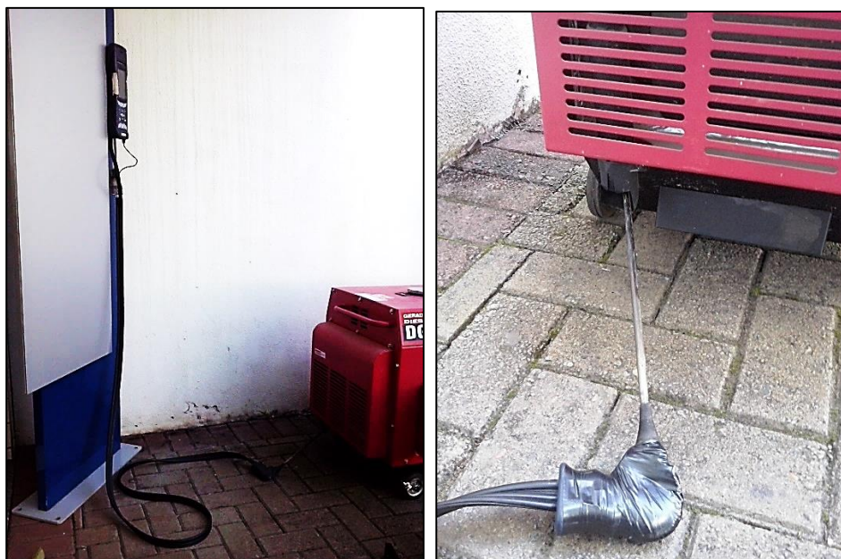
Figura 17: Instalação da sonda de amostragem dos gases. Fonte: do autor.
