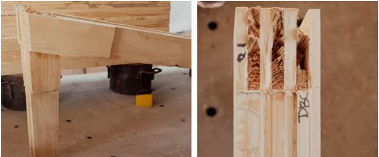
Figura 18 – Detalhes de ruptura do pórtico 1, nó C, vistas lateral e interna.
