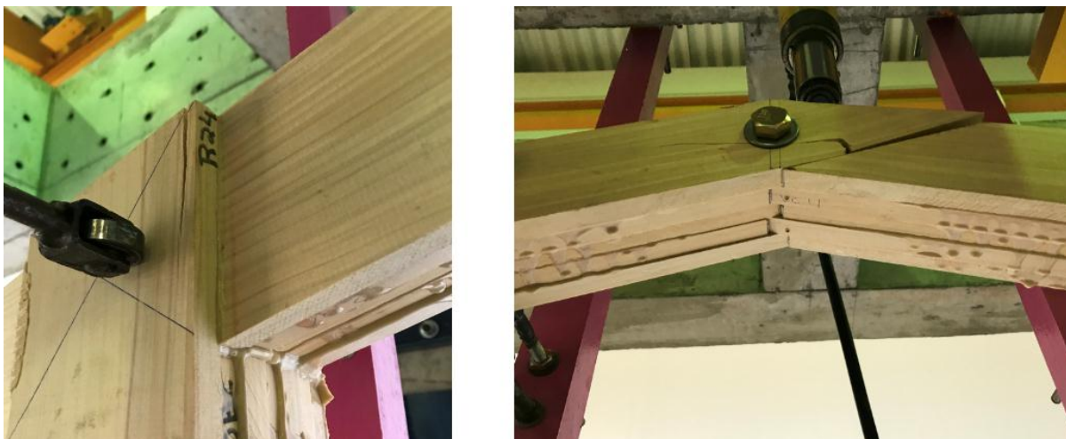
Figura 22 – Detalhes de ruptura do pórtico 5, vista frontal dos nós C e D, respectivamente.
