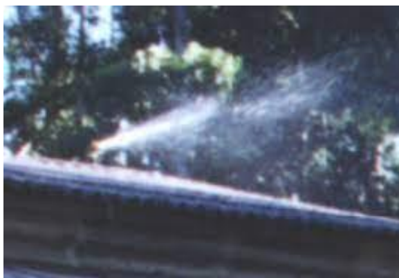
Figura 6 - Resfriamento da cobertura do aviário por aspersão Fonte: Embrapa, 2005.
