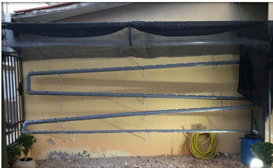
Figura 8. Estrutura do sistema hidropônico vertical.
