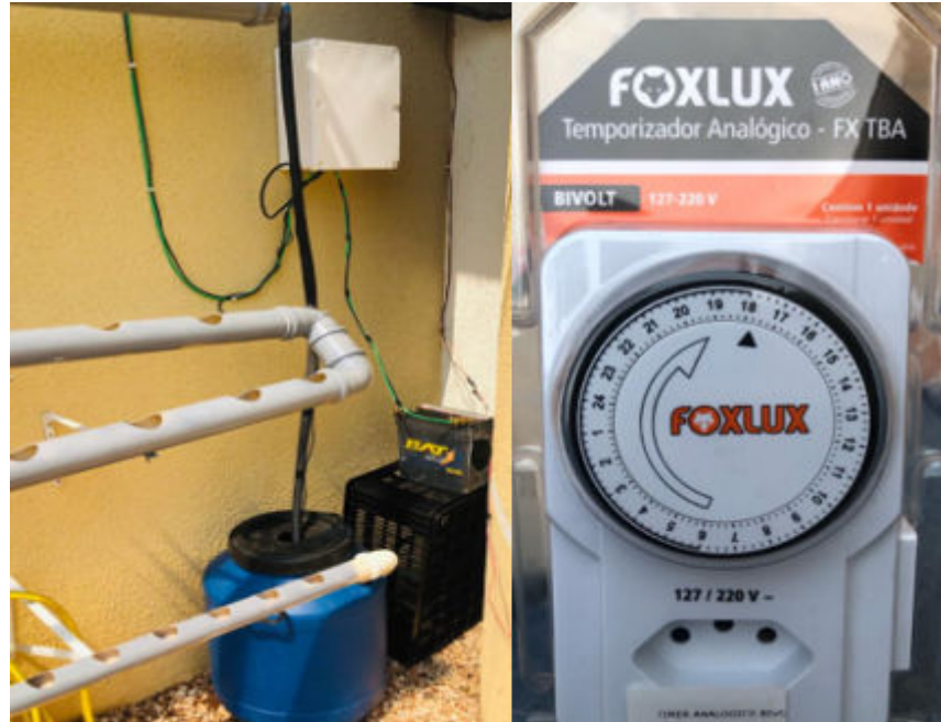
Figura 13. Reservatório para solução nutritiva / mangueira e programação do temporizador.
