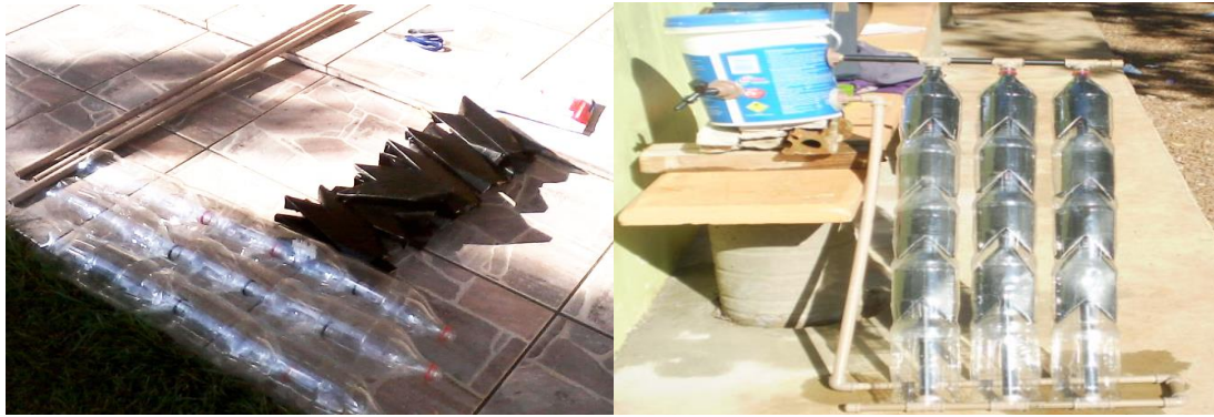
Figura 1: Fotos dos materiais utilizados para fazer o aquecedor e o aquecedor solar pronto. Fonte: Aline Viana e Rafaela G. Rauber, 2012.
