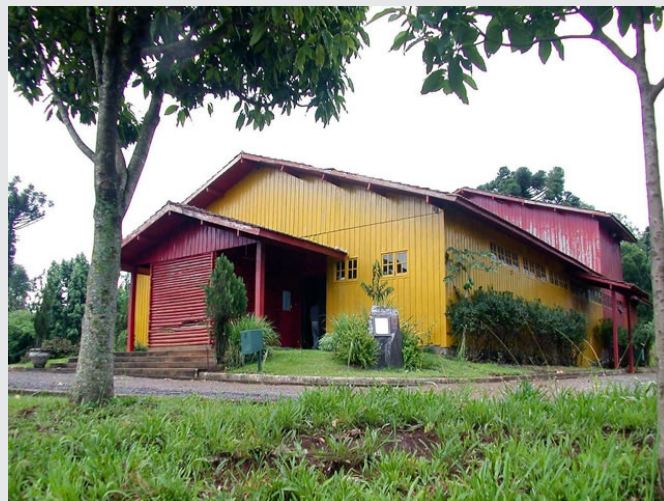
Teatro Barracão antes de sua demolição
